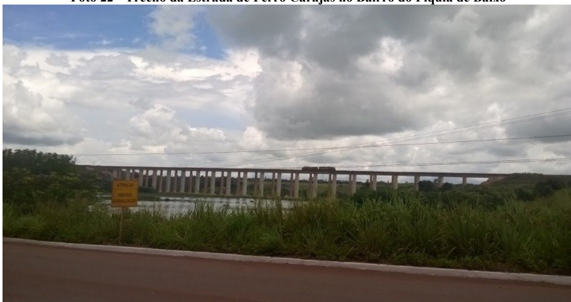
Foto 22 - Trecho da Estrada de Ferro Carajás no Bairro do Piquiá de Baixo
