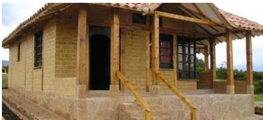
Figura 02 - Construção com blocos de adobe
