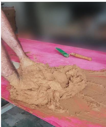
Figura 26 – Mistura manual da fibra do epicarpo do babaçu com a massa do adobe
