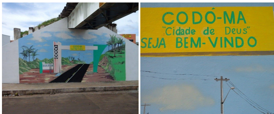
(figura 2 e 3: fotografias do viaduto que corta a rua Colatino Borborema. Fonte: arquivo pessoal da pesquisadora)
