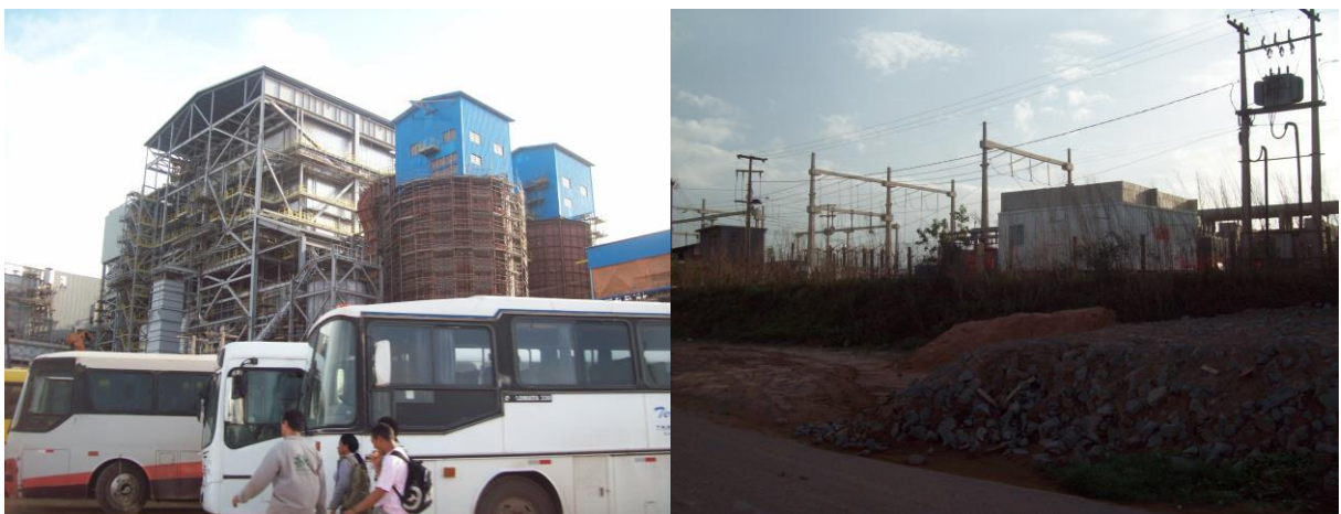
FOTO 7 - INSTALAÇÕES DA TERMOELÉTRICA MPX
