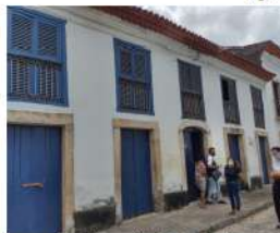
Fachada casarão Rua da Estrela
