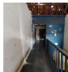
Corredor do pavimento superior
