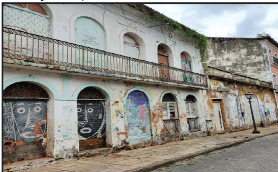
Imagem 26 - Empreendimento habitacional Rua da Palma, n.º 445/459
