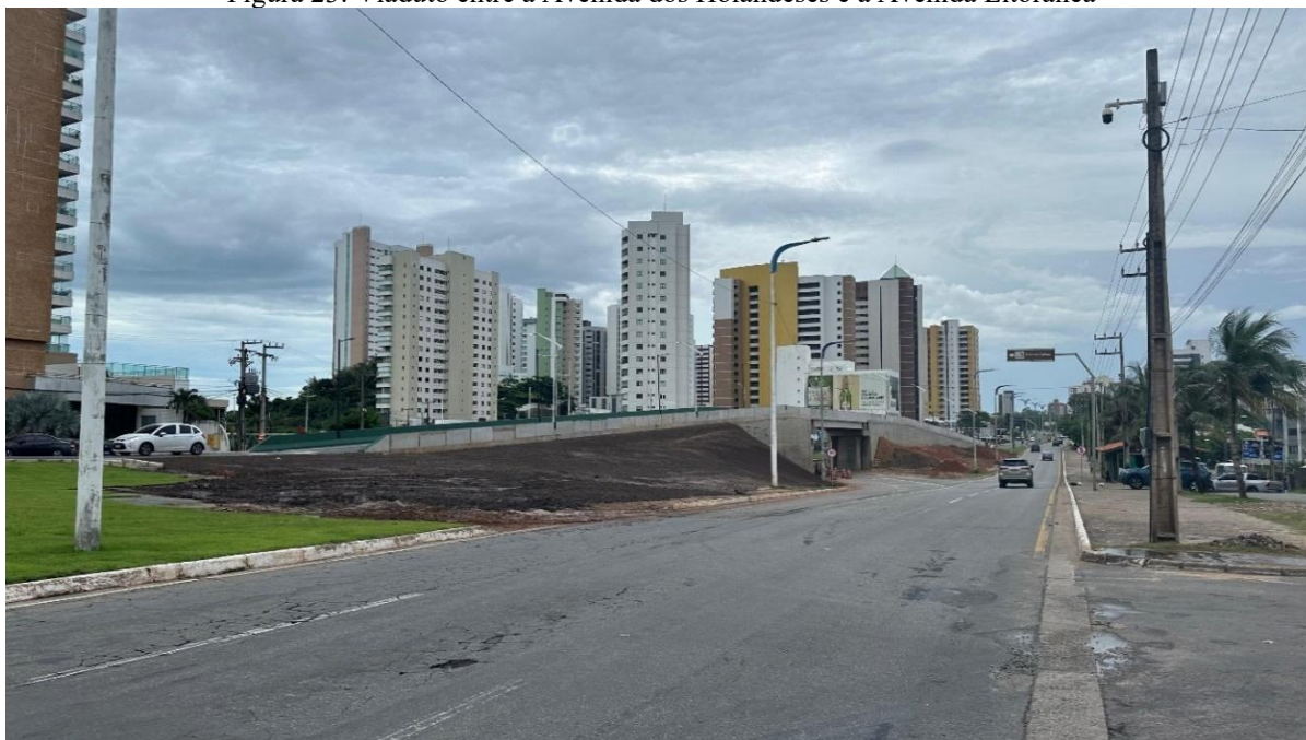
Figura 23: Viaduto entre a Avenida dos Holandeses e a Avenida Litorânea
