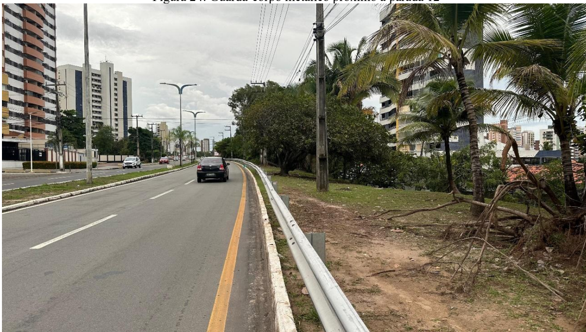
Figura 24: Guarda-corpo metálico próximo a parada 12
