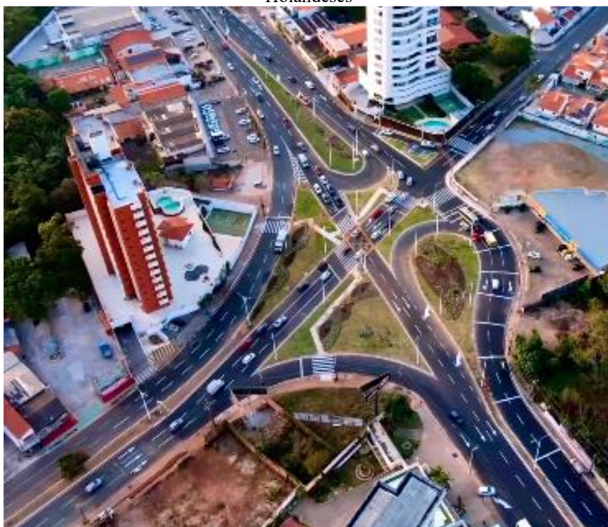
Figura 10: Finalização da obra de intervenção da conexão da Avenida Daniel de La Touche e a Avenida dos Holandeses
