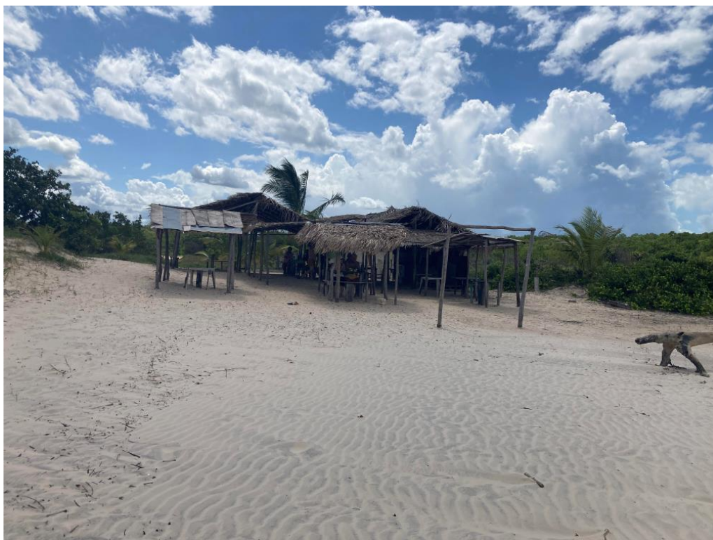
Fotografia 12 - Único local (barraca) para atendimento aos banhistas na praia de Itatinga
