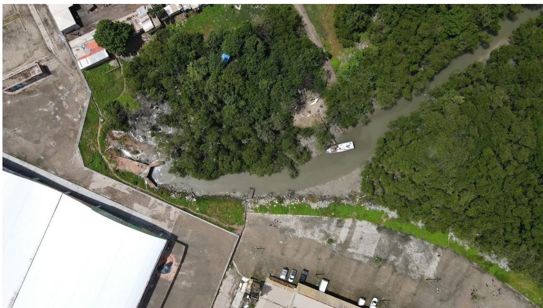
Figura 10. Vista aérea do Portinho, revelando a estruturação precária da área e a falta de infraestrutura adequada. Fonte: Autoria Própria (2025).
