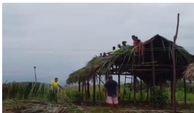
Figura 15 - Trabalho comunitário na cobertura de uma casa de taipa
