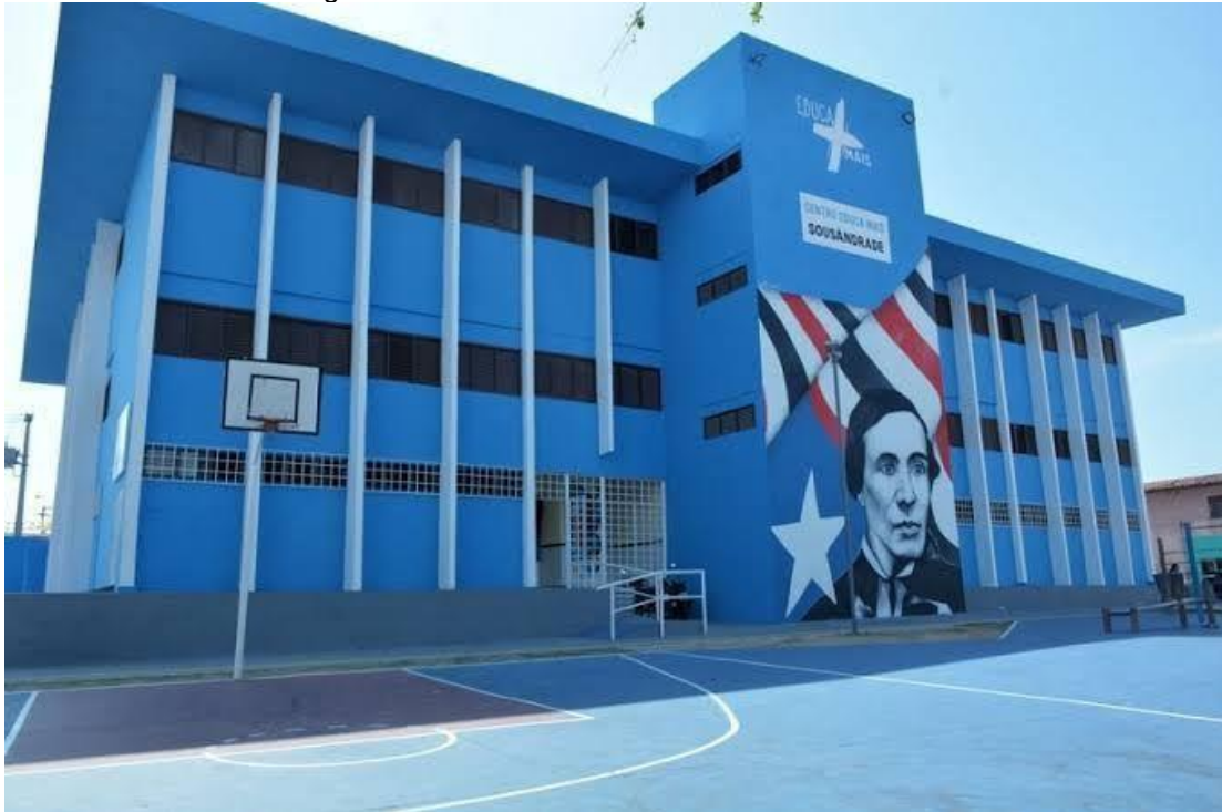
Figura 1 - Fachada do IEMA Pleno Sousândrade
