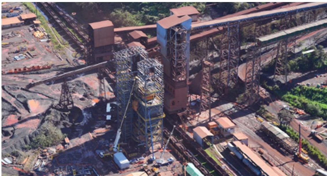
Figura 31 – Silos de Carregamento (Vale, 2013)
