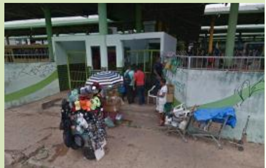
Entrada da Av. 04 do terminal de integração a Cohab/Cohatrac Fonte: o Autor
