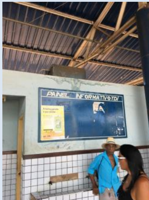
Painel de informativo do terminal do Distrito industrial.
