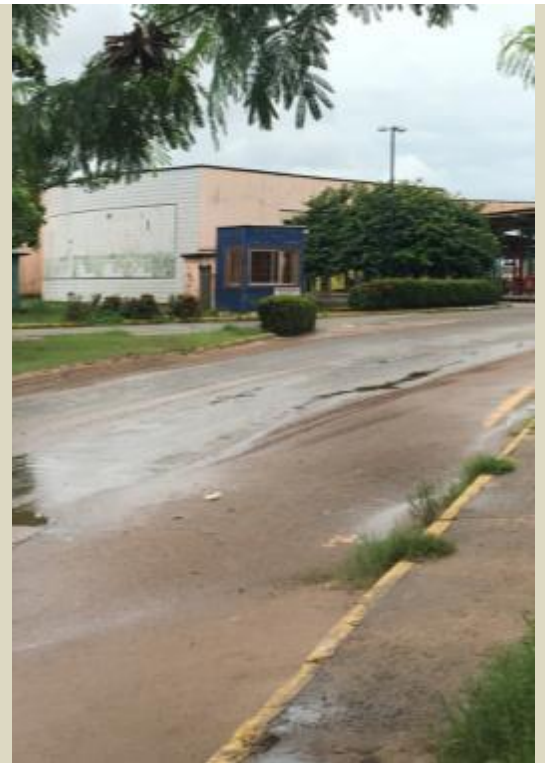
Cabine de controle do terminal sem utilização do terminal da Praia Grande.
