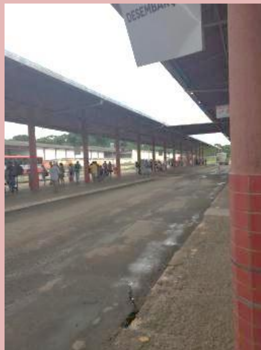
Parte interna do terminal Cohama/Vinhais, destaque na conexão das plataformas. Fonte: Autor
