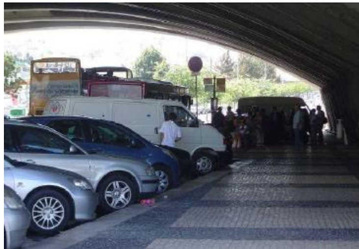
Figura 14- Estacionamento do Gare Intermodal Lisboa
