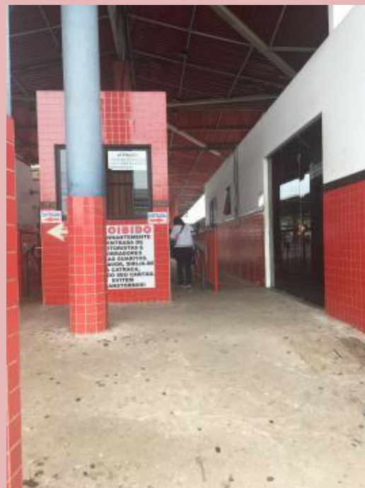
Acesso ao terminal COHAMA/Vinhais Fonte: Autor
