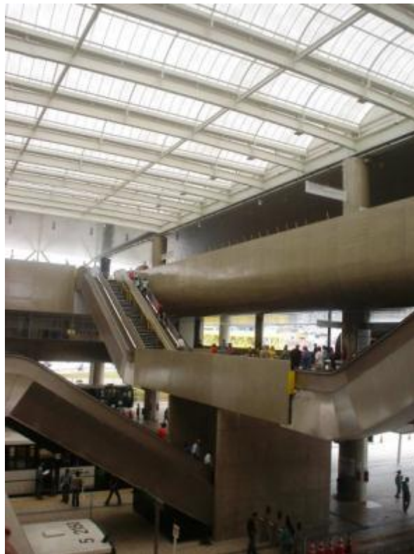
Figura 15 – Átrio com iluminação zenital e escadas rolantes
