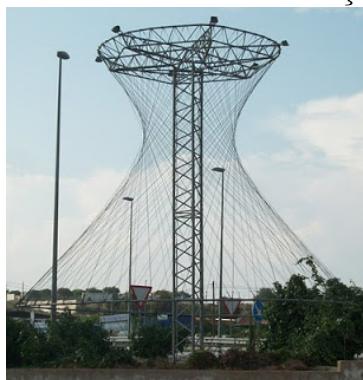
Figura 5.6: Estrutura de Sustentação em Aço
