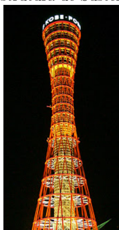
Figura 5.5: Estrutura de Sustentação em Aço
