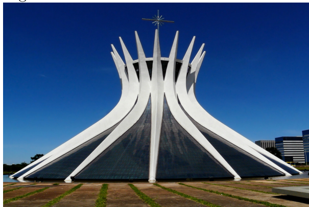
Figura 5.4: Fachada da Catedral de Brasília
