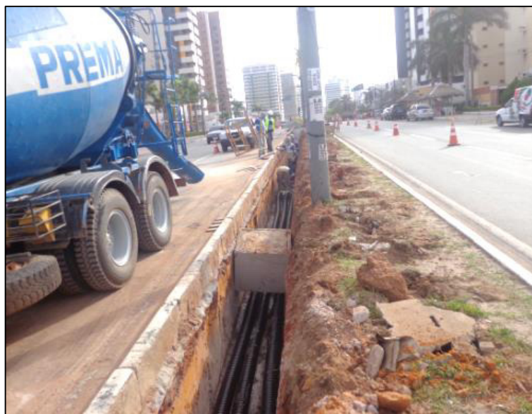
Figura 20 - Implantação de LT subterrânea em São Luís - MA
