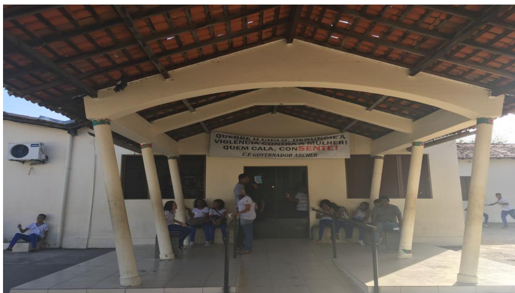
Figura 19: Rampa de acessibilidade do C.E Governador Archer Fonte: Pesquisa Empírica
