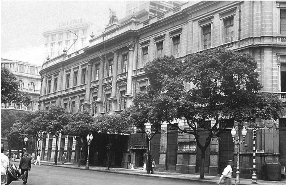
Figura 11: Fachada do Liceu de Artes e Ofícios no Rio de Janeiro.
