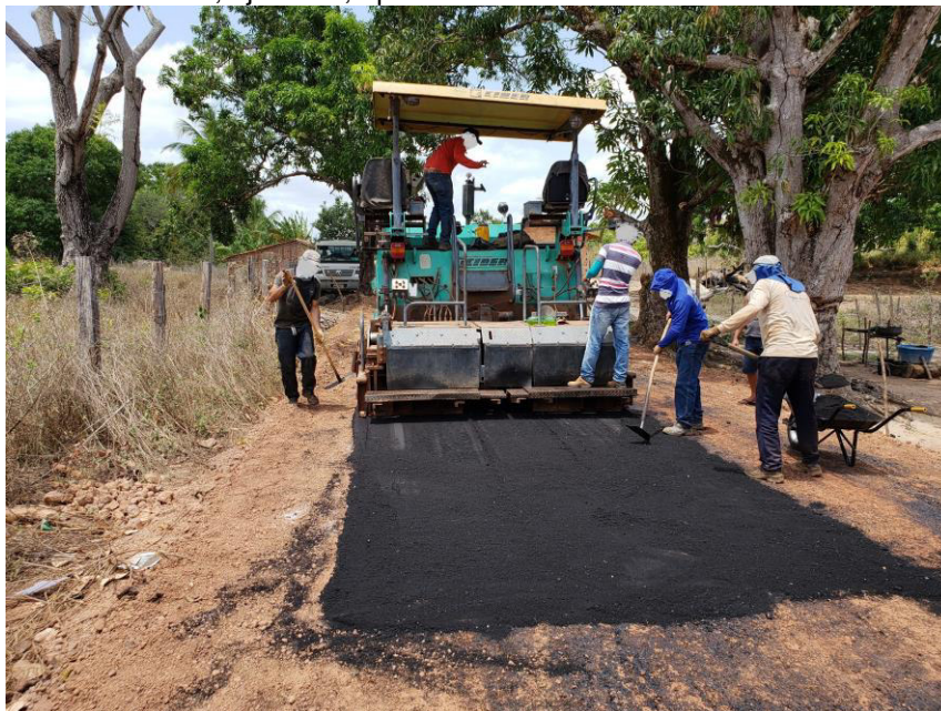
Figura 13 - Rasteleiros, ajudante, operador da vibroacabadora e mesista em atividade
