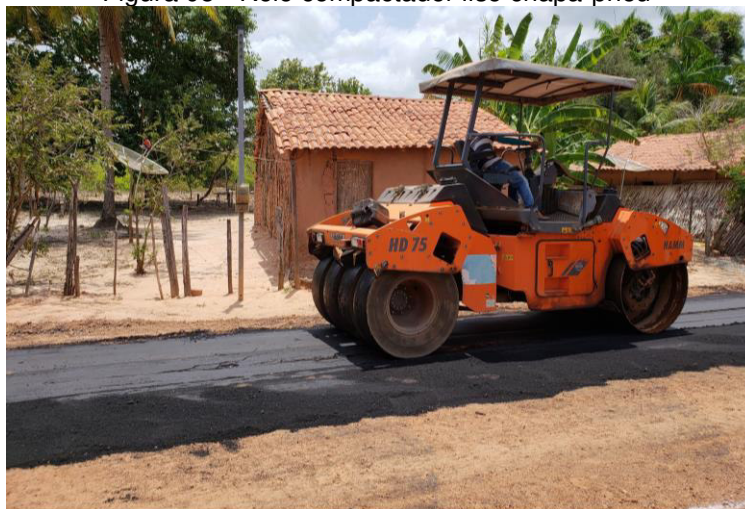
Figura 08 - Rolo compactador liso chapa-pneu
