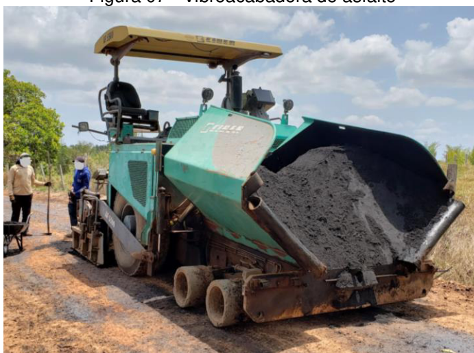
Figura 07 - Vibroacabadora de asfalto
