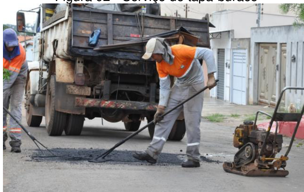
Figura 02 - Serviço de tapa-buraco
