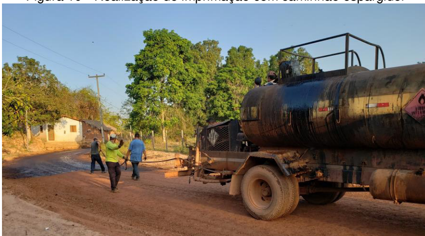
Figura 10 - Realização de imprimação com caminhão espargidor
