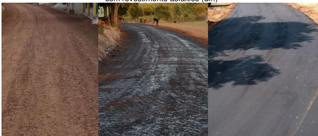
Figura 01 - Pavimento sem revestimento asfáltico (esq.), pavimento imprimado (centro) e pavimento com revestimento asfáltico (dir.)
