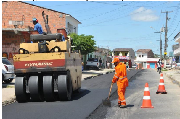
Figura 03 - Serviço de recapeamento
