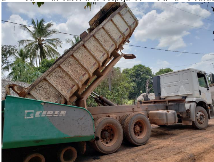
Figura 12 - Caminhão basculante despejando AAUQ na vibroacabadora
