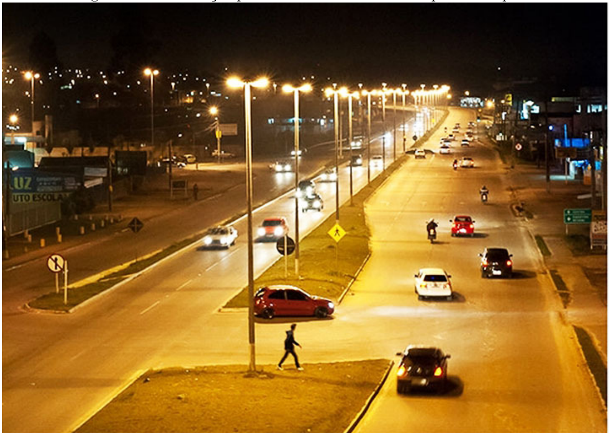
Figura 2.5 – Iluminação pública convencional com lâmpada de vapor de sódio
