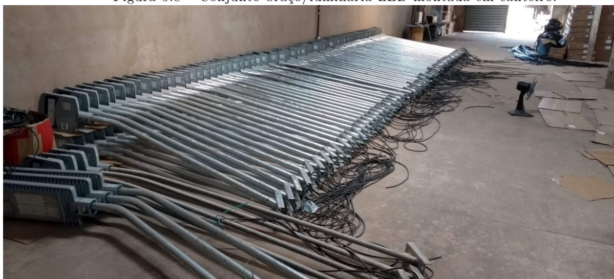
Figura 5.8 – Conjunto braço/luminária LED montada em canteiro.
