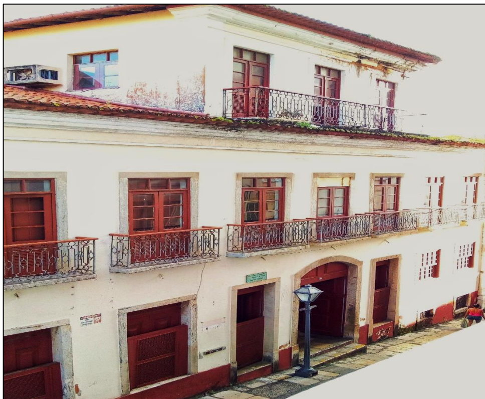
Figura 8. Prédio do Arquivo Público do Estado do Maranhão
