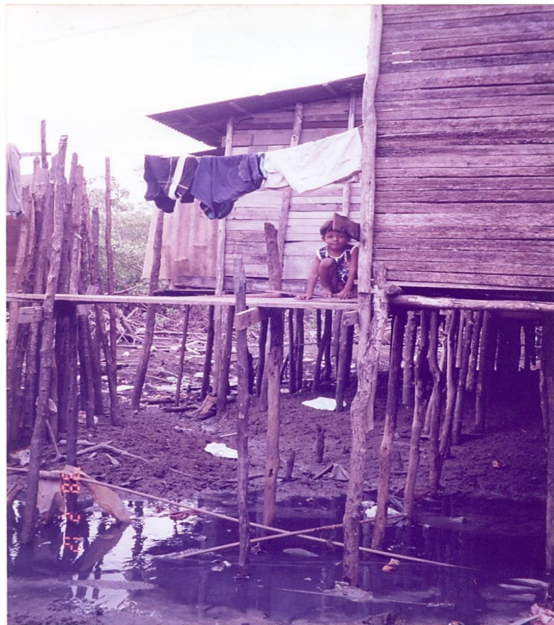
Figura 6 - Palafita construída fora de área aterrada
