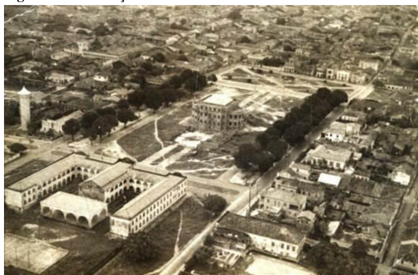
Figura 8 – Construção da Biblioteca Pública Benedito Leite.
