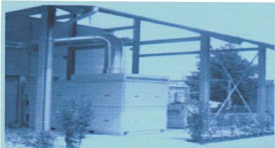
Figura 12 – Conjunto microturbina-gerador da Capstone Turbine Corporation.
