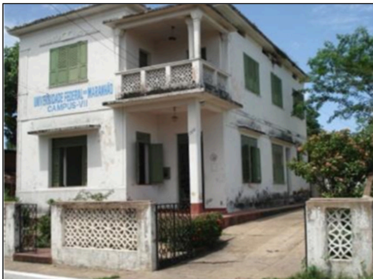
Figura 14: Primeiro prédio da UFMA em Codó e sede do CRUTAC- década de 1980.
