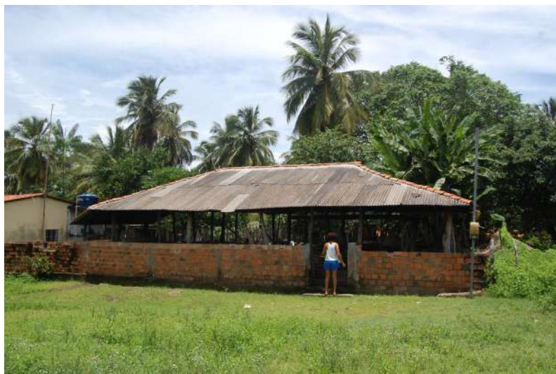
Figura 35 – Casa de Forno com cobertura de telha de fibrocimento em Canelatiua
