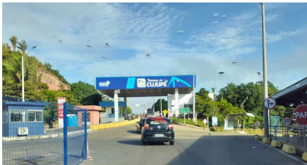
Figura 17 – Terminal do Cujupe no município de Alcântara
