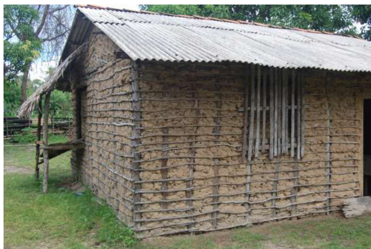
Figura 34 – Casa de taipa com cobertura de telha de fibrocimento em Canelatiua
