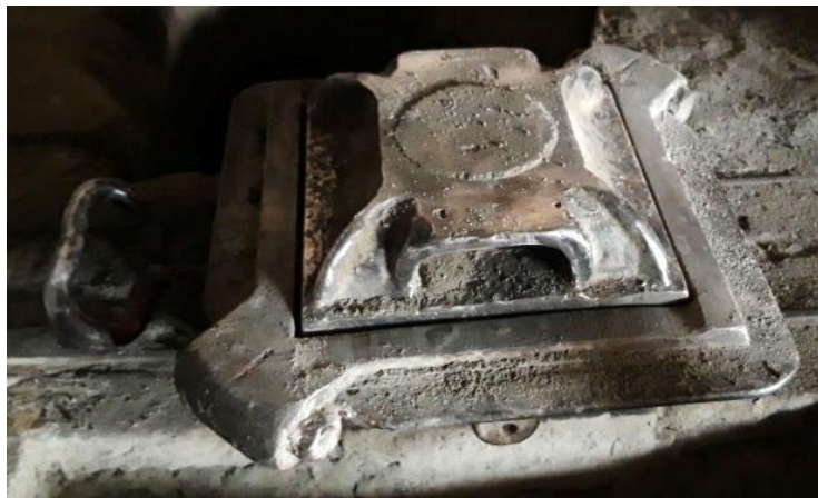
Figura 24: Aplicação da tampa de metal pesada.
