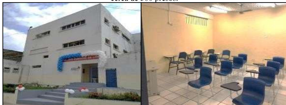
Figura 7 – Fachada atual da escola e uma sala de aula, ambas após passarem por revitalização para atenderem cerca de 500 presos.
