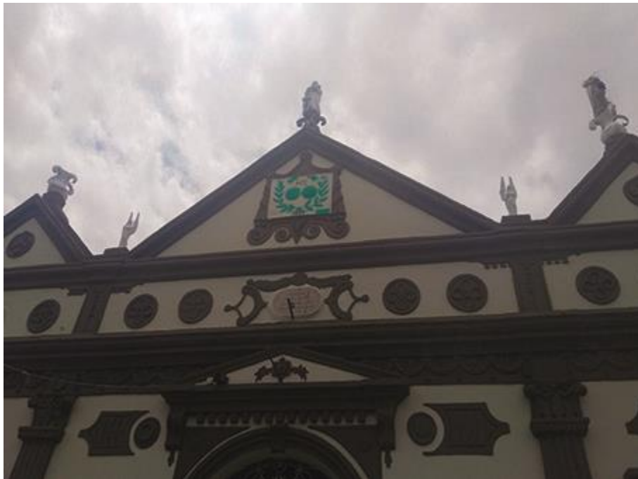
Figura 10 – Fachada principal da Capela de São José, Cemitério do Gavião.
