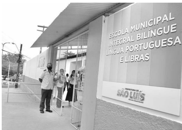
Figura 6 – Fachada externa da Escola
