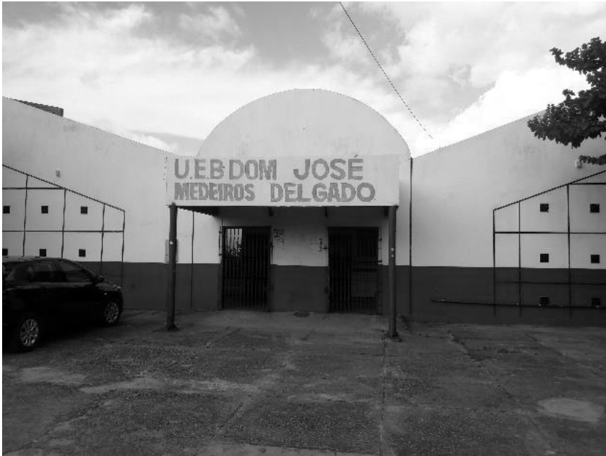
Fotografia 2 – Fachada da Escola
