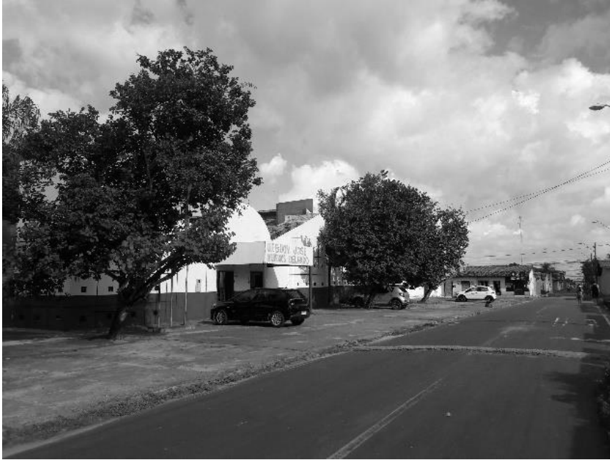
Fotografia 1 – Rua da UEB Dom Delgado
