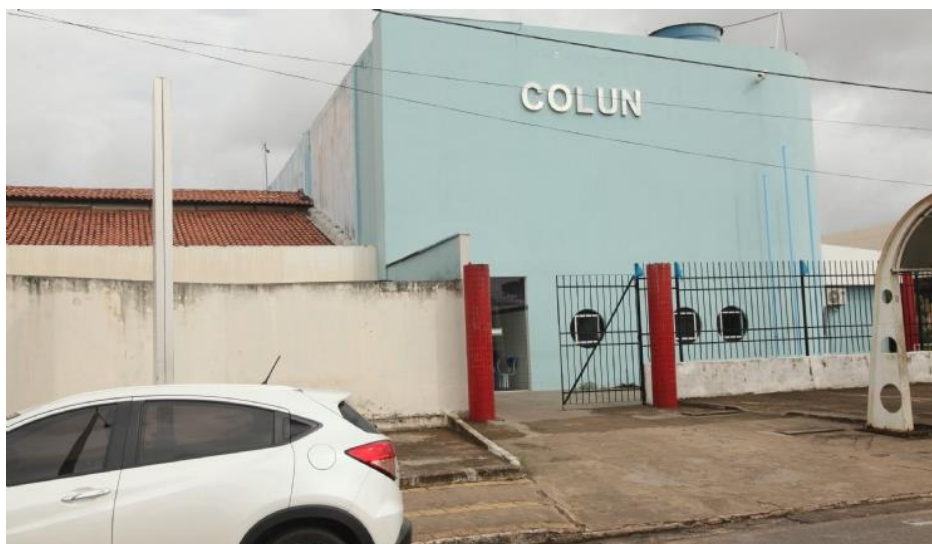
Figura 6 – Fachada do Colégio de Aplicação da Universidade Federal do Maranhão
