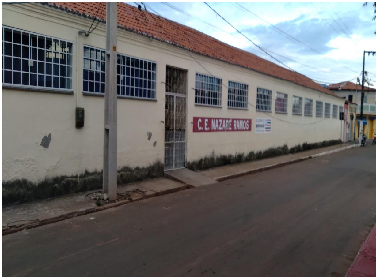
FIGURA 1 – Fachada da escola C. E. Nazaré Ramos.
