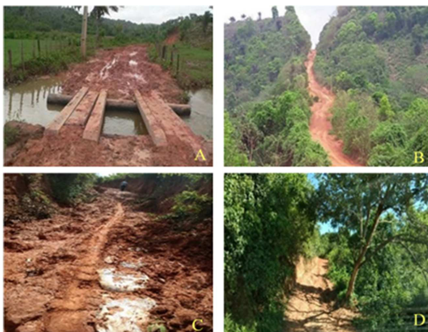
Figura 04 – Imagem da infraestrutura da malha das vias vicinais (fig.4A – ponte de madeira em precárias condições de uso; fig. 4B, C e D, todas no período de chuvas ficam intrafegáveis), no município de Arame (MA, Brasil).
