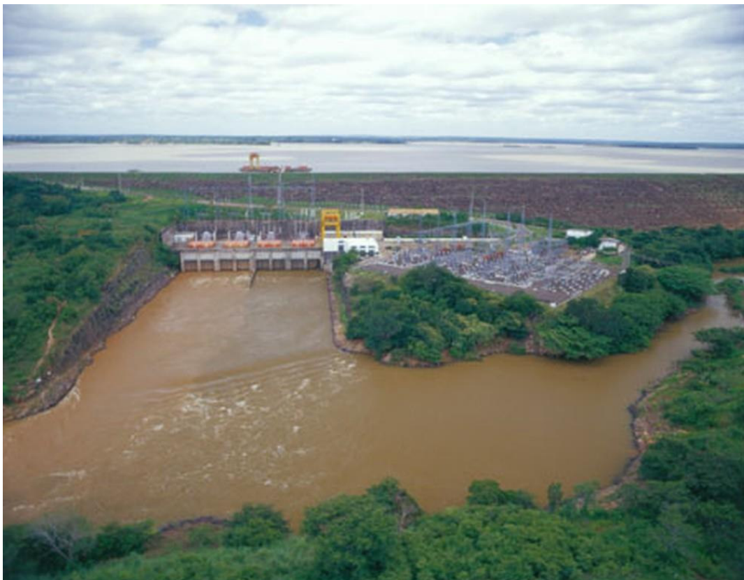
Figura 12 – Imagem da Barragem de Boa Esperança no estado do Piauí 45 .
