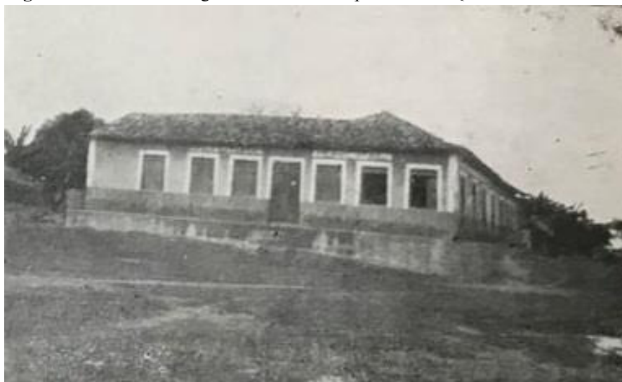
Figura 9 – Prédio da antiga Prefeitura Municipal de Santa Quitéria do Maranhão
