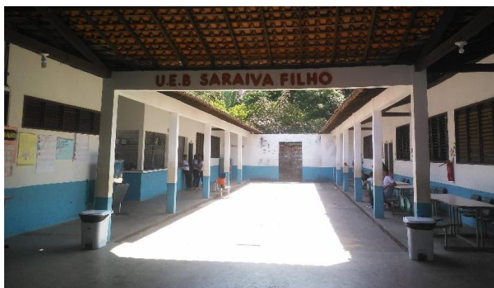
Imagem 36 – Pátio da UEB Saraiva Filho
