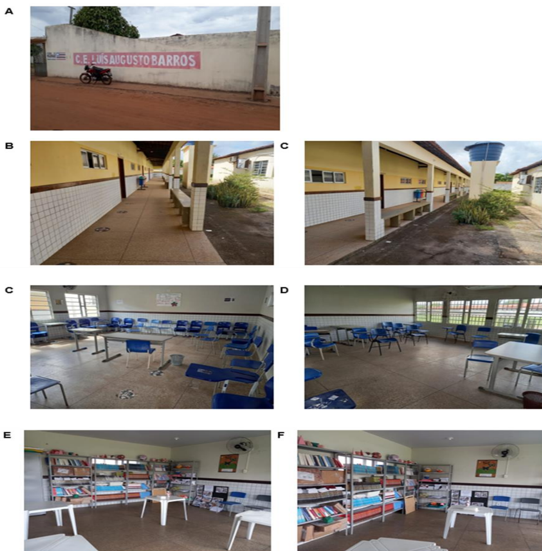
A: Frente da escola; B-C: quantitativo de salas de aula (09 salas); D-E: Estrutura de algumas salas de aula; E-F: Espaço físico da biblioteca da escola; G: Frente da sala dos professores; H: Espaço físico interno da sala dos professores; I: Mural de informações da escola; J: Espaço para prática exercícios físicos; K: Frente da secretaria da escola; L: Sala da direção.
