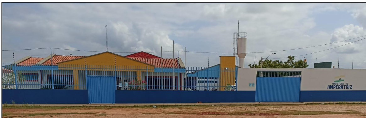
Imagem 1 – Fachada da EMEI Shirley Torres Farias.
