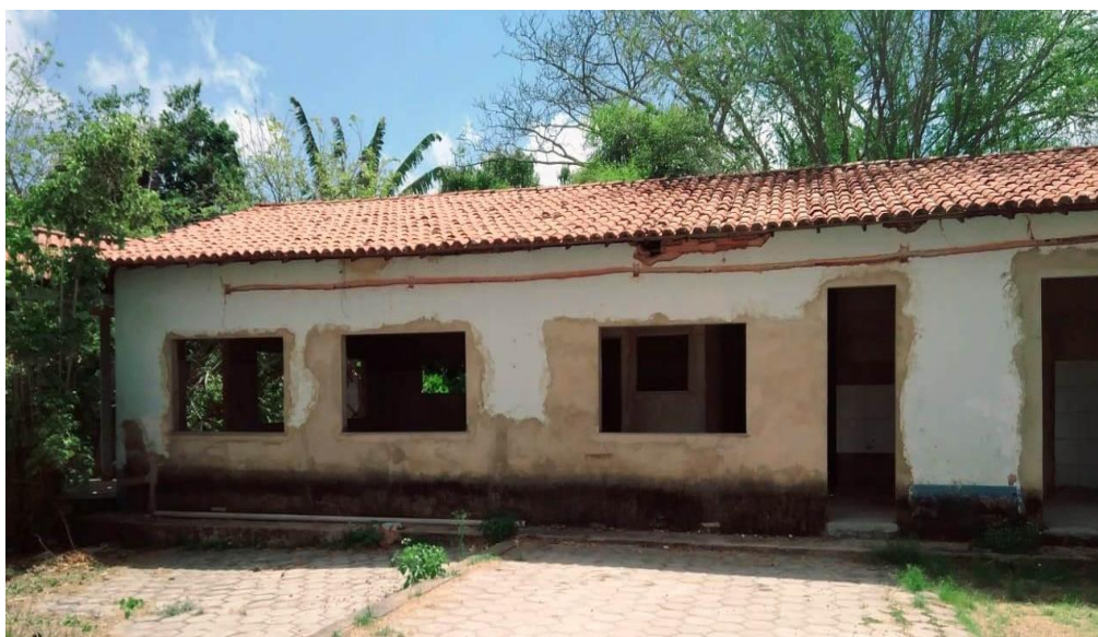
Figura 13 - Antiga cozinha durante a reforma.
