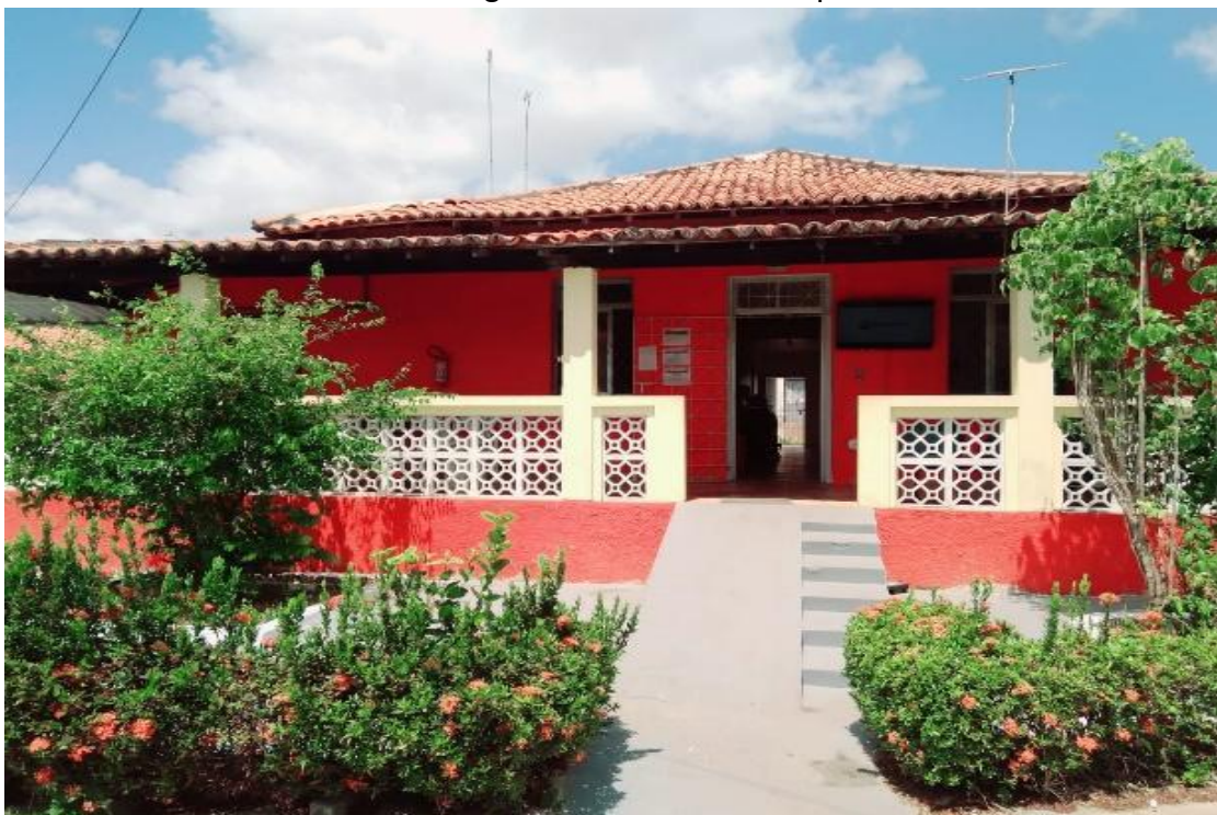
Figura 16 - Unidade de apoio.
