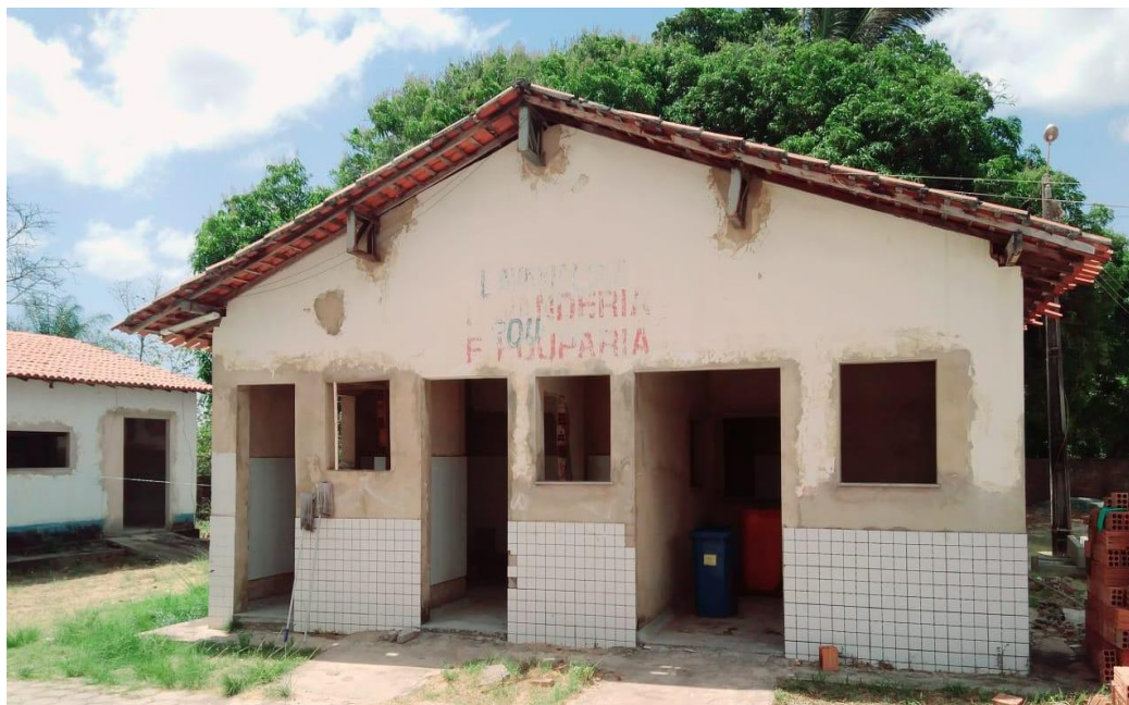
Figura 12 - Lavanderia e rouparia durante a recente reforma no Hospital.
