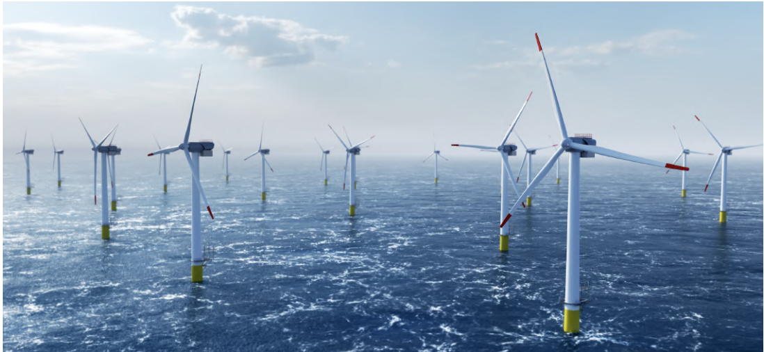
Figura 2.2: Parque eólico offshore Hornsea 2: 165 turbinas Siemens Gamesa 8MW, capacidade de mais de 1,3 GW, localizado a aproximadamente 89 km da costa de Yorkshire, no Mar do Norte Hornsea 2 [34]
