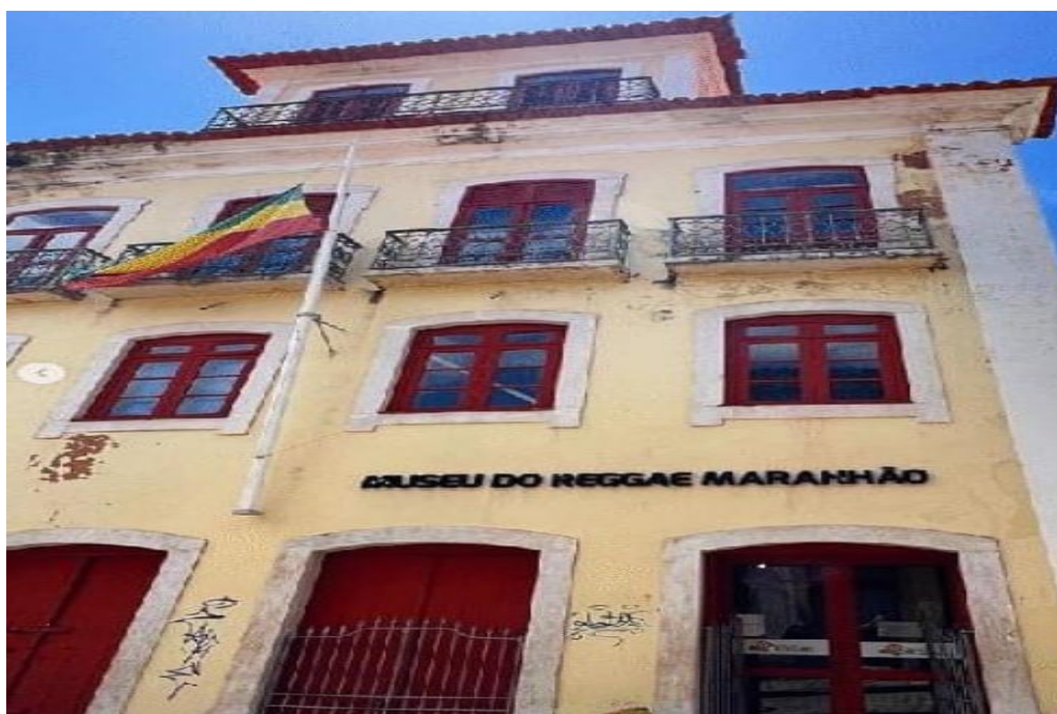
Figura 13 – Fachada do Museu
