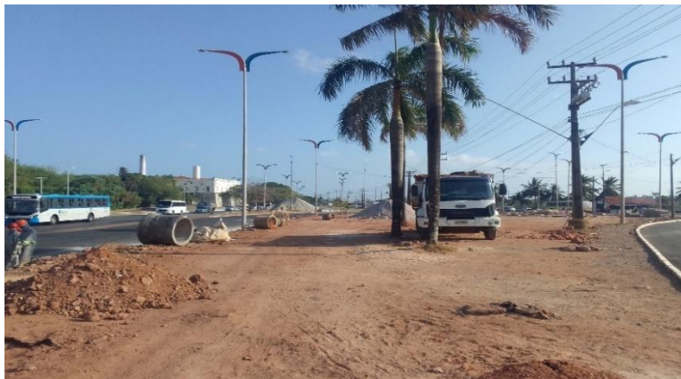
Foto 1- Avenida Vitorino Freire em obras no dia 21 de outubro de 2022
