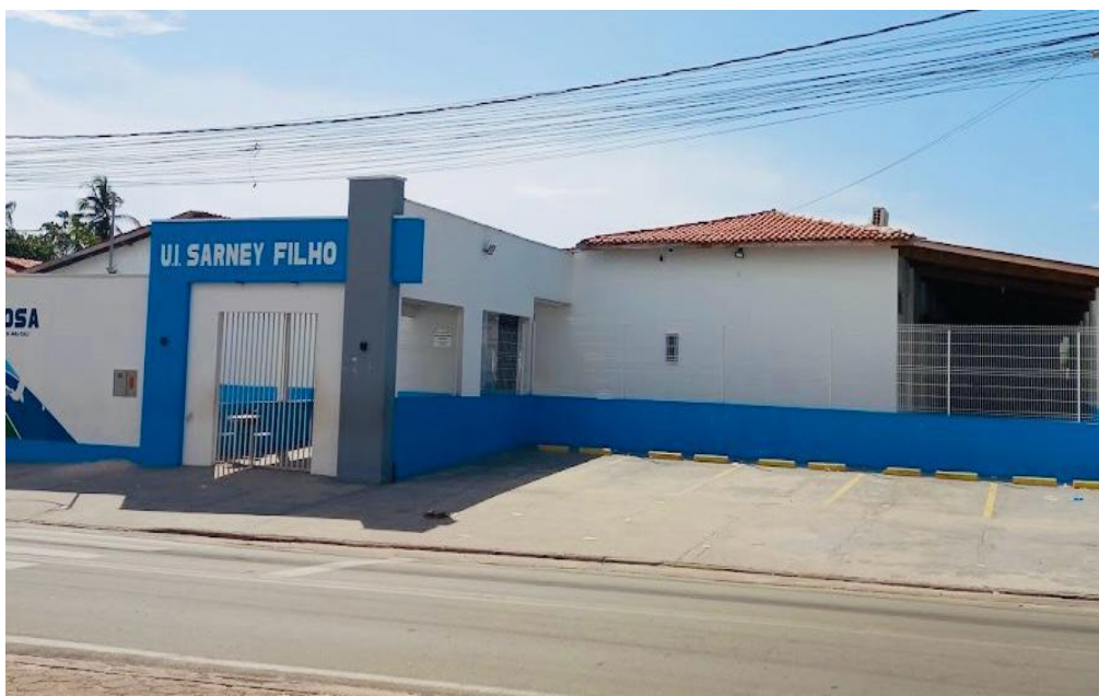
Figura 3- Fachada Nova após a reforma da U.I Sarney Filho Raposa MA 2023
