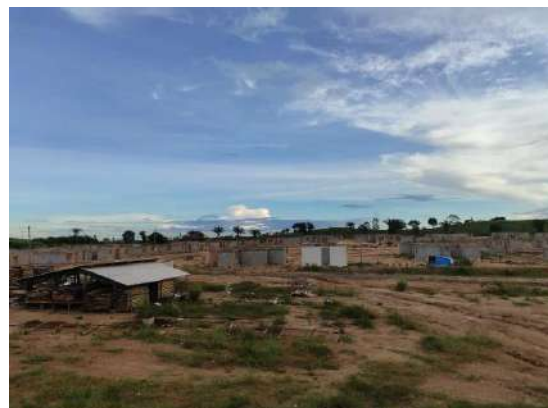
Figura 49 - Casas em Construção (2020). Fonte - Mikael Carvalho.
