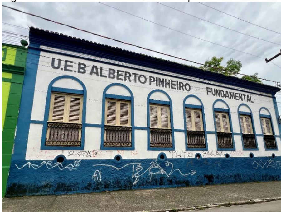
Figura 22 - Prédio tombado da UEB Sotaque da Baixada
