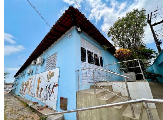
Figura 1 – Fachada interna da sede administrativa da FUNAC
