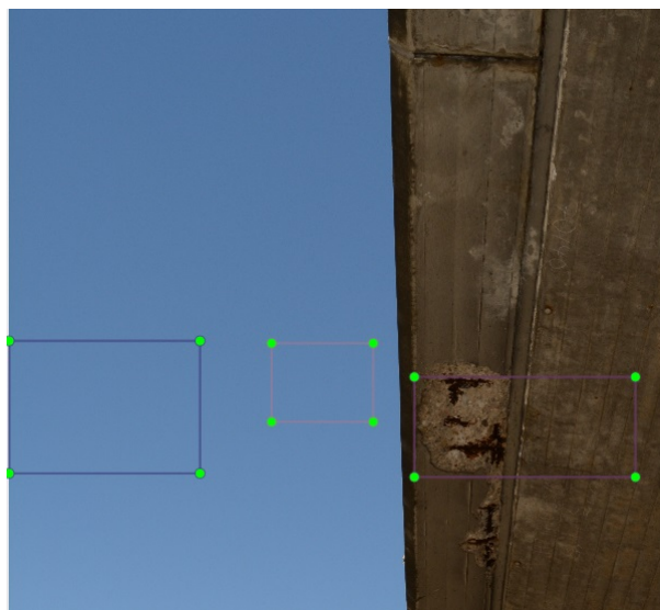
Figura 16 – Anotação incorreta devido ao giro na imagem. Elaborada pelo autor.
