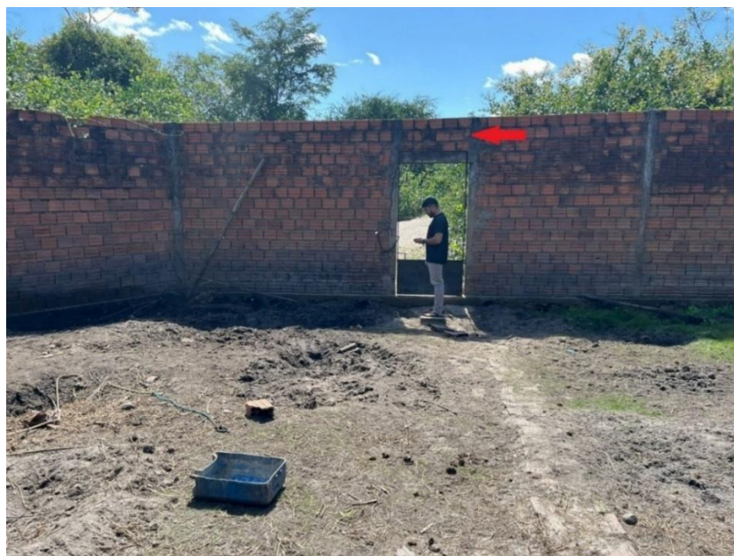
Figura 37: Nível do rio Mocambo, em 2020, rua São Sebastiao.
