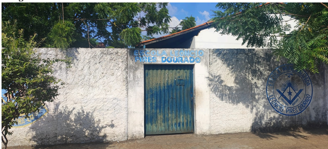
Figura 12: Fachada da EMLPD.
