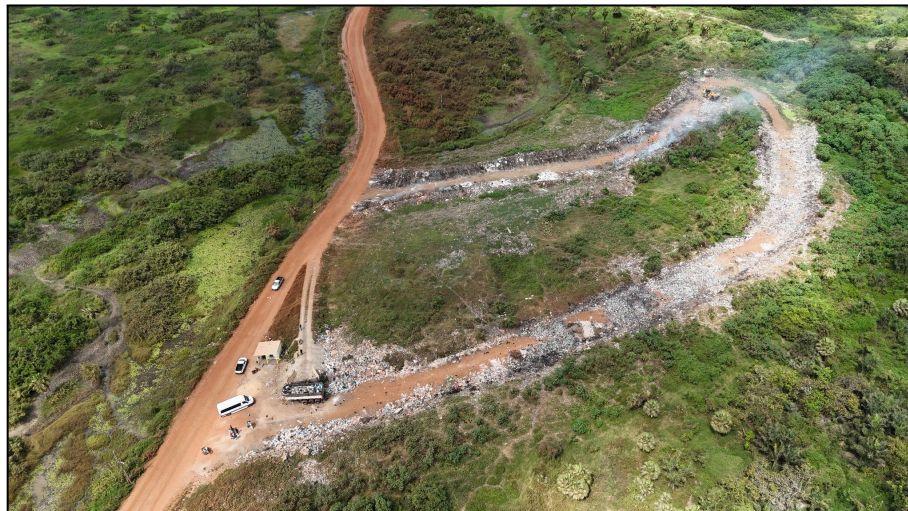
Figura 21- Vista aérea oblíqua do lixão e estação de transbordo do município de Arari, 2025.
