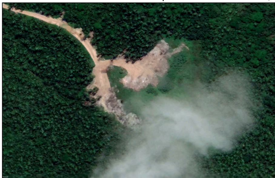
Figura 58 - Vista aérea do lixão do município de Santa Helena-MA, 2019.
