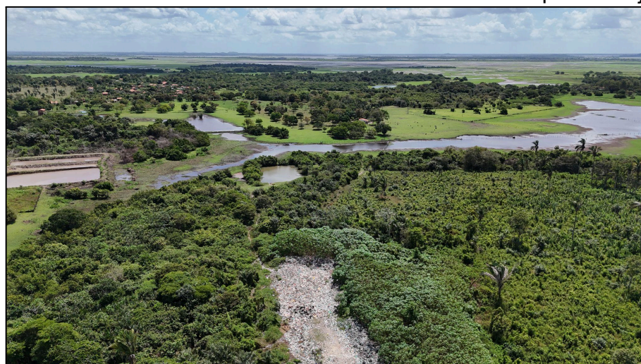
Figura 27 - Vista aérea do entorno ao fundo do lixão do município de Cajari, 2025.
