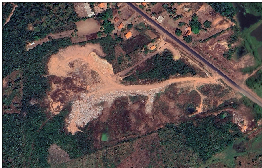
Figura 66 - Vista aérea do lixão do município de São Vicente Ferrer-MA, 2025.
