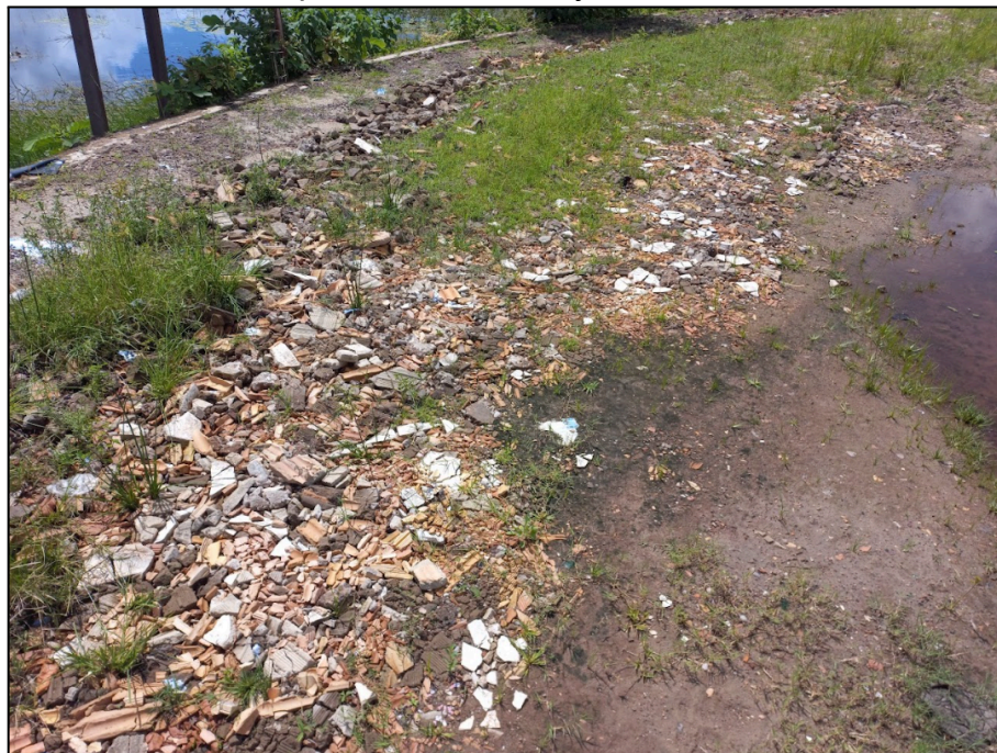
Figura 48 - Resíduos da construção civil sendo utilizado em terraplenagem na cabeceira da ponte José Sarney, Pinheiro - MA, 2024.
