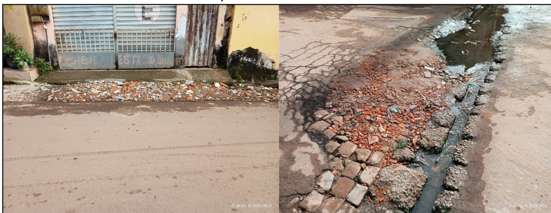
Figura 71 - Exemplos da utilização de RCC para pavimentação e aterramento no município de Viana-MA, 2025.
