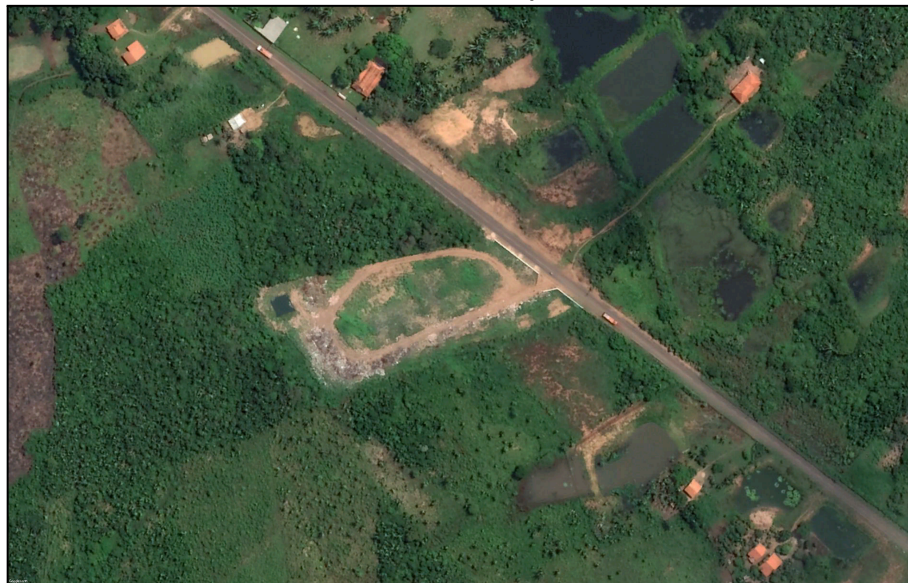
Figura 68 - Vista aérea do lixão do município de São Vicente Ferrer, 2017.
