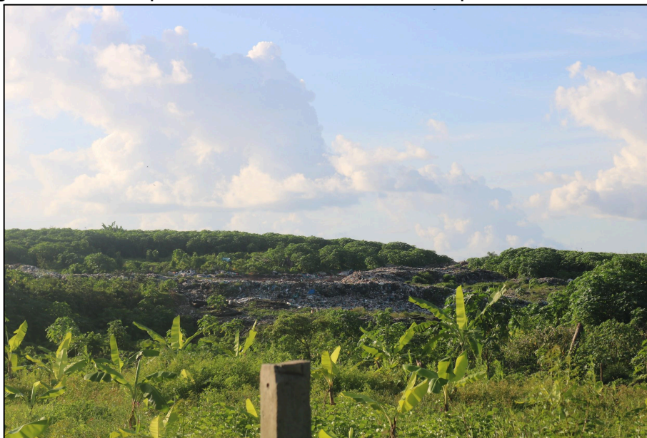
Figura 52 - Vista panorâmica do lixão do Município de Pinheiro, 2024.
