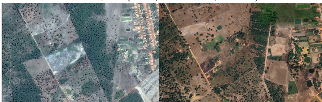
Figura 79 - Vista aérea do antigo lixão do município de Vitória do Mearim-MA (ano de 2014, à esquerda; ano de 2024, à direita).
